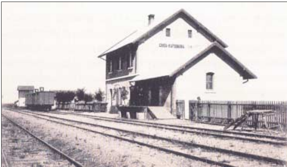
Εικόνα 1. Ο σιδηροδρομικός σταθμός στο Γιδά 1 .
